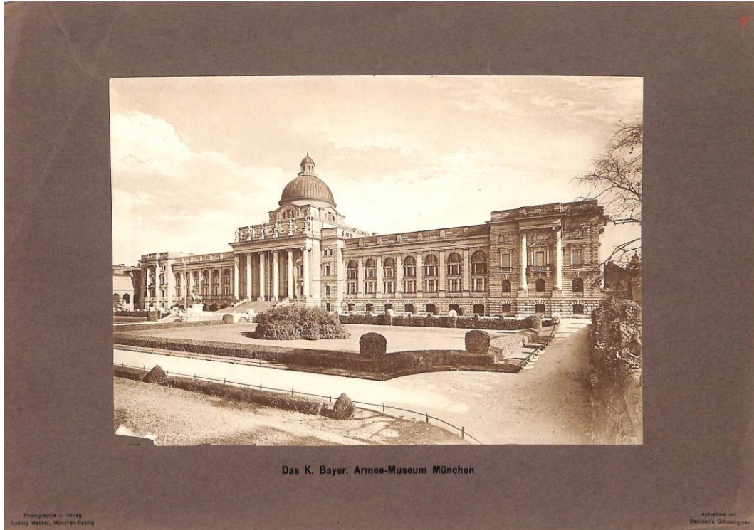
Abb. 4: Das Armeemuseum im Hofgarten (zweiter Bau), Signatur: N 3218-0001, Bayerisches Armeemuseum Ingolstadt (Fotomappe Ludwig Wacker: Das Königlich Bayerische Armee-Museum in 50 Kunstblättern, München 1913).
